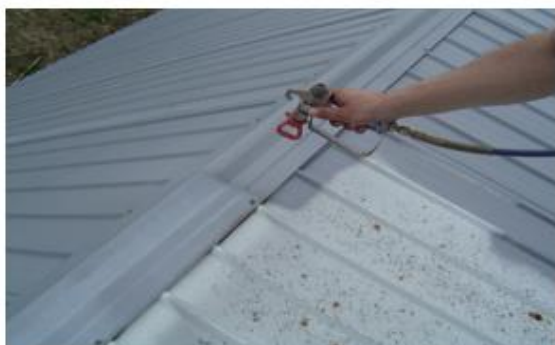
Рисунок 13 Обработка конькового нащельника
