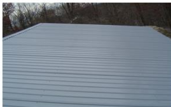
Рисунок 14 Кровля укрыта покрытиеи GE Enduris
