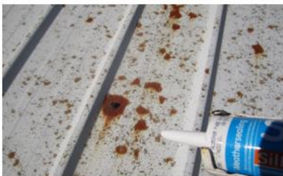
Рисунок 7 Заполните небольшие дырки герметиком
