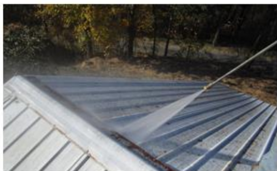
Рисунок 9 Мойка под давлением гребня
