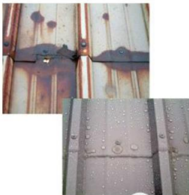
Рисунок 5 GE Enduris позволяет реставрировать кровлю с поверхностной ржавчиной
