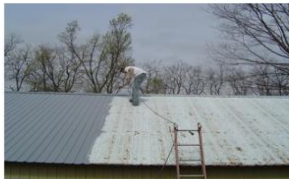
Рисунок 10 Тщательная промывка кровли
