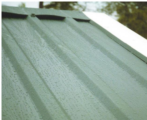
Рисунок 4 Вид металлической кровли с покрытием
