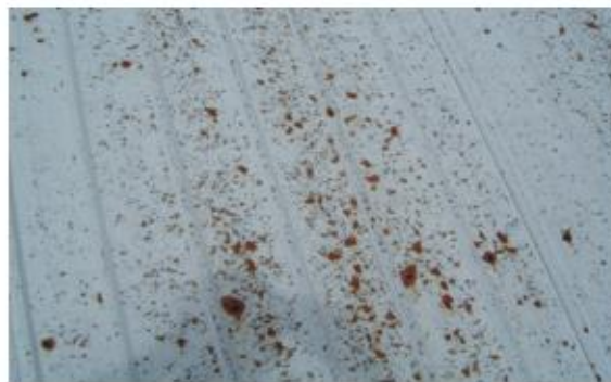
Рисунок 6 Металлическая кровля до покрытия
