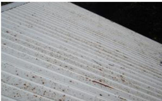
Рисунок 5 Металлическая кровля до покрытия
