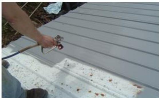
Рисунок 11 Нанесение покрытие на панели
